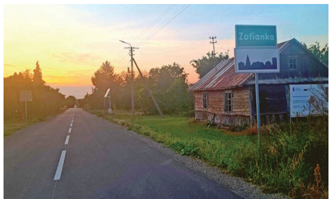
Przebudowa drogi w miejscowości Zofianka
