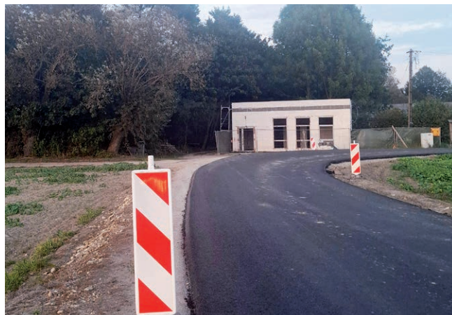
Świetlica wiejska, przebudowa drogi gminnej w miejscowości Kocianów
