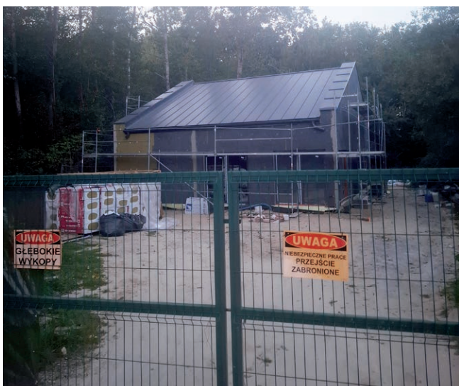
Świetlica wiejska Wólka Łubkowska
