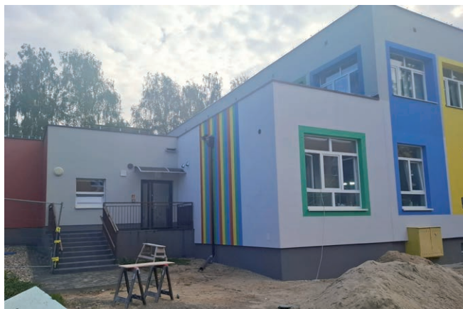
Rozbudowa Żłobka Miejskiego w Poniatowej
