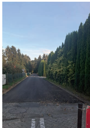
Przebudowa dróg gminnych - obręb Henin
