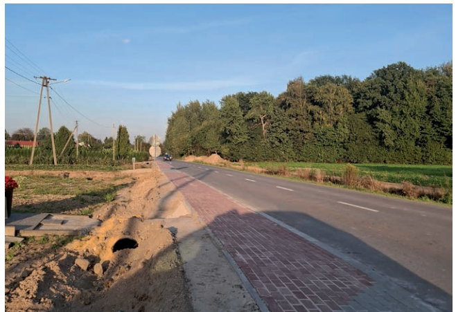
Budowa chodnika w miejscowości Szczuczki
