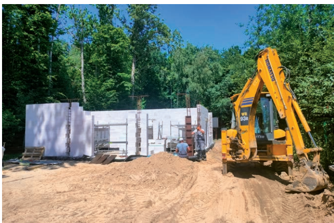
Budowa świetlicy wiejskiej w miejscowości Wólka Łubkowska
