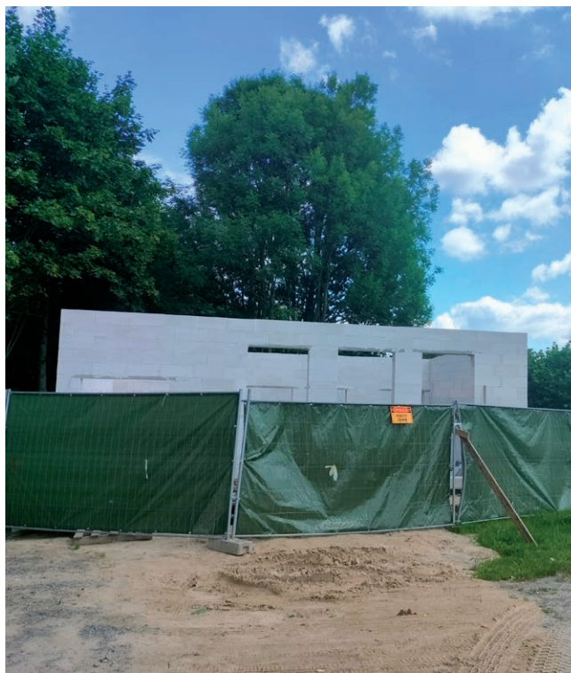
Budowa świetlicy wiejskiej w miejscowości Kocianów
