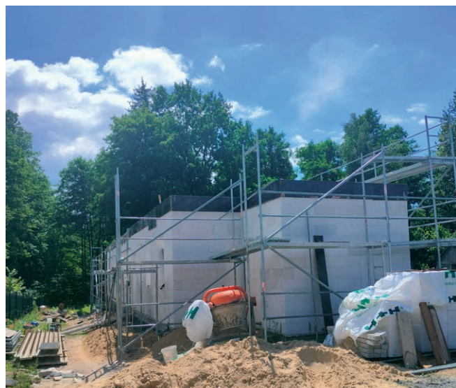
Budowa świetlicy wiejskiej w miejscowości Plizin
