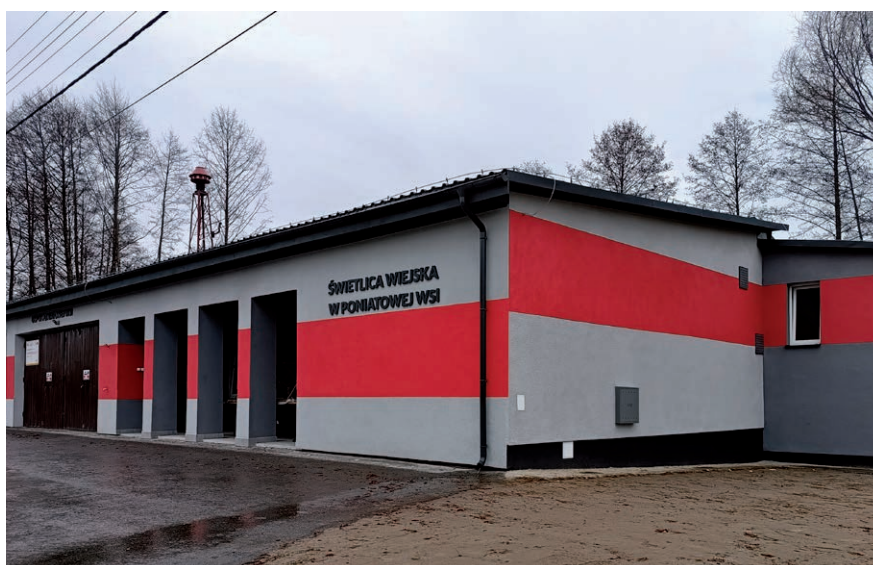
Fot. Budynek OSP i Świetlicy Wiejskiej po zakończeniu robót
