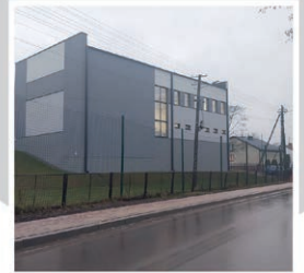
8. Budowa chodnika przy drodze powiatowej w Kraczwicach Prywatnych na dt. 1,146 km i Szczuczkaż Kolonii na dt. 2,359, a także budowa chodnika Poniatowej Kolonii od remizy OSP do szkoły podstawowej
