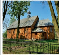
2. Wykonanie prac konserwatorskich i robót budowlanych przy budynku Kościoła pw. Najświętszego Serca Pana Jezusa w Kraczwicach
