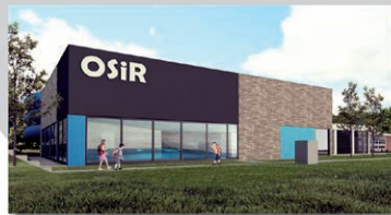
12. Modernizacja budynków w miejscowościach
