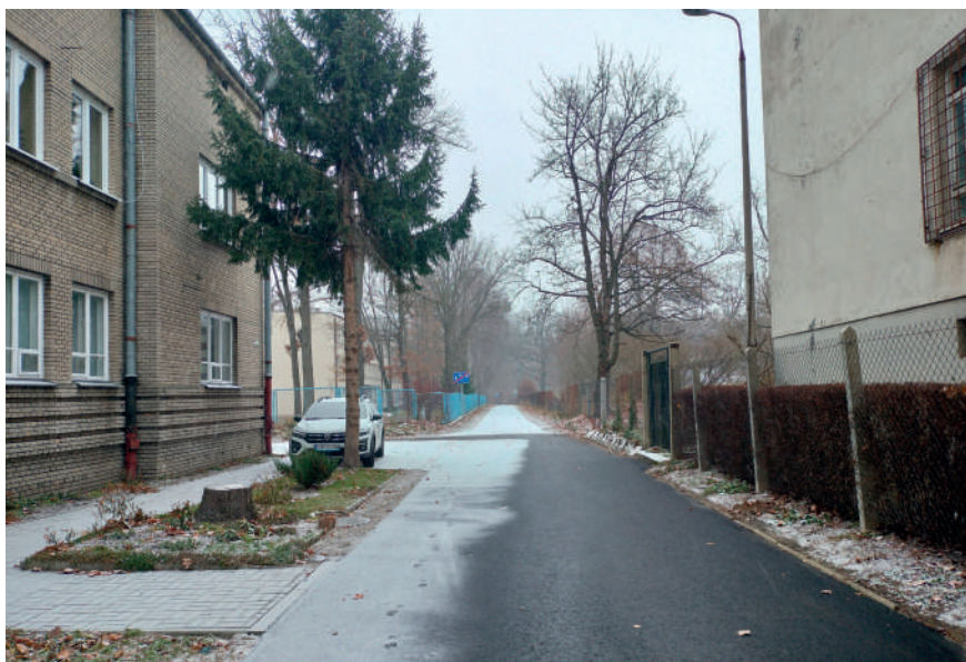
Droga wewnętrzna przy ul. Fabrycznej
