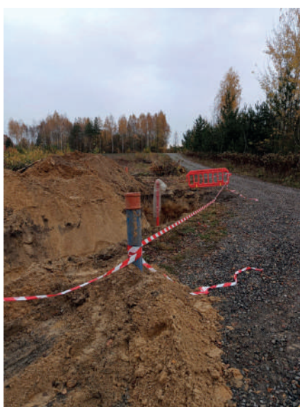
Budowa wodociągu na os. Henin w Poniatowej
