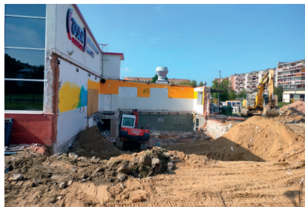
Roboty rozbiórkowe prowadzone w związku z rozbudową krytej pływalni w Poniatowej
