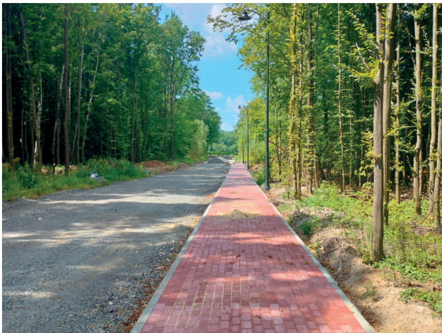
Nowy odcinek ul. Lubelskiej w Poniatowej
