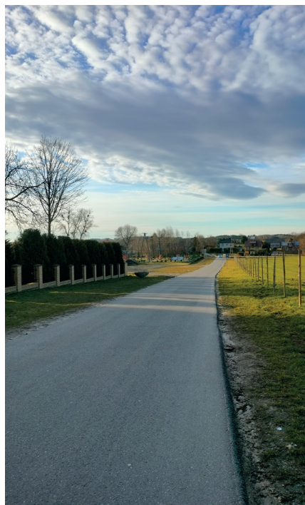
Droga w Kraczewicach Prywatnych, przy której prowadzone będą roboty budowlane związane z budową chodnika.
