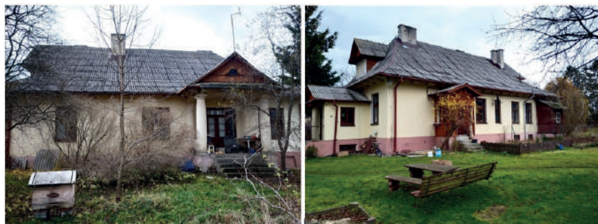
Budynek leśniczówki-widok od strony wschodniej i zachodniej
